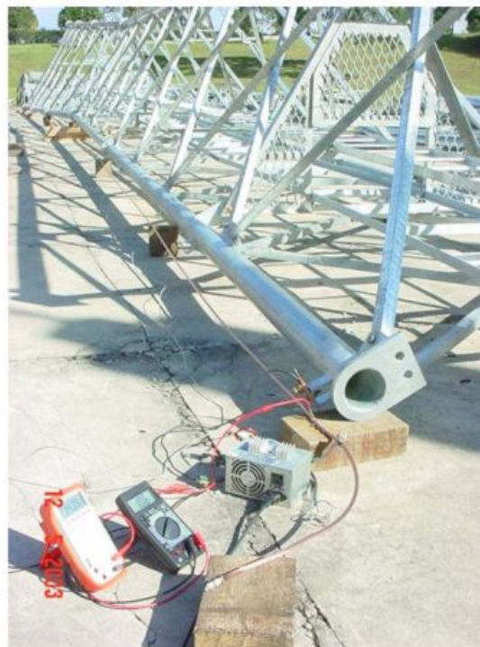
Foto 1 - Ensaio da torre Detalhe dos multímetros e da fonte
