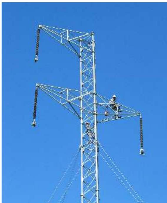
Torre TET em montagem Monomastro Suspensão para LT de 460 kV
