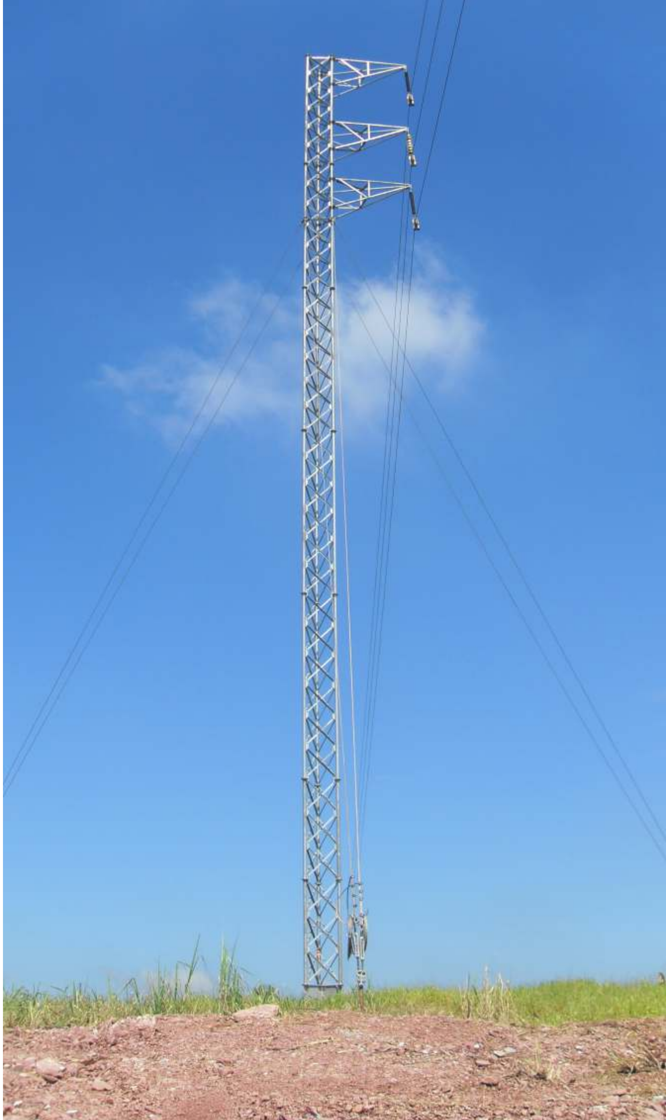
Torre TET em montagem Monomastro Suspensão para LT de 460 kV
