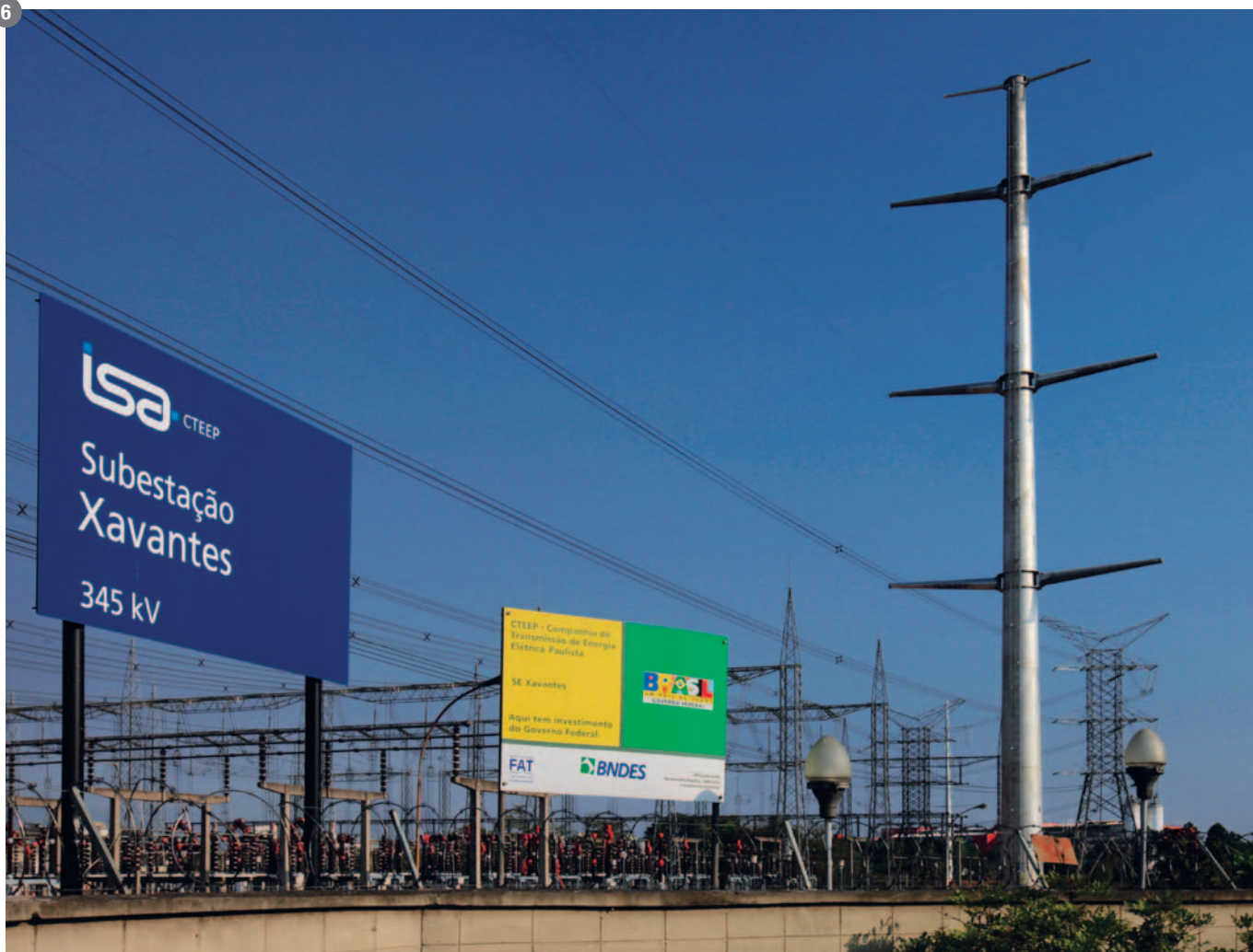
Torre instalada e aguardando cabeamento
