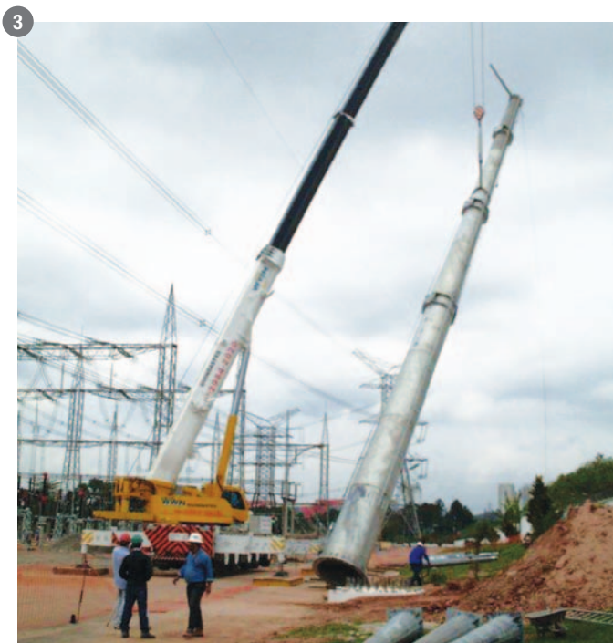
3 Içamento da torre
