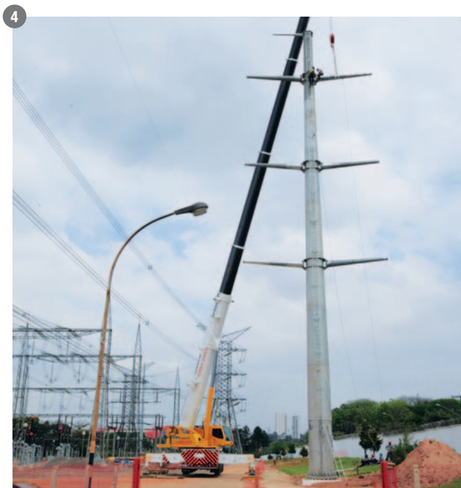
2 As seções de no máximo 6m de comprimento são facilmente encaixadas pelo processo "Slip Joint"
