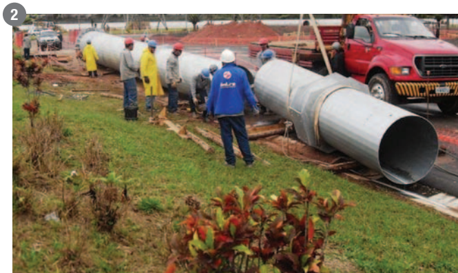
2 As seções de no máximo 6m de comprimento são facilmente encaixadas pelo processo "Slip Joint"
