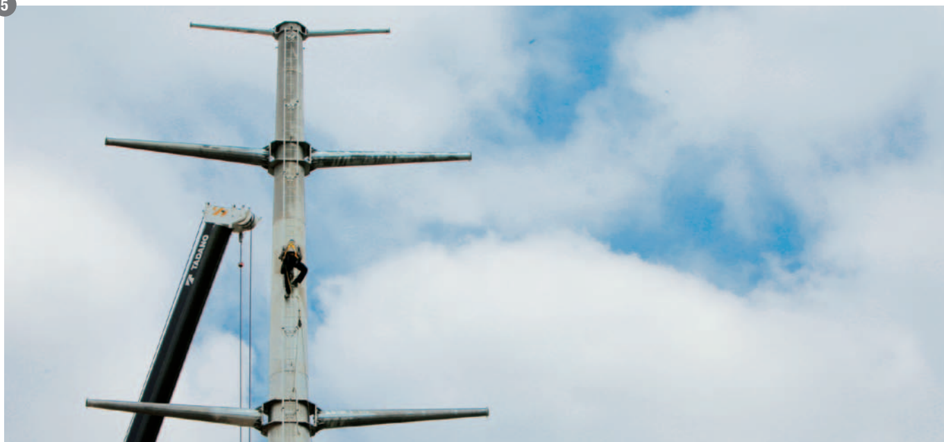
Mísulas de 4,5m ensaiadas para 6 toneladas
