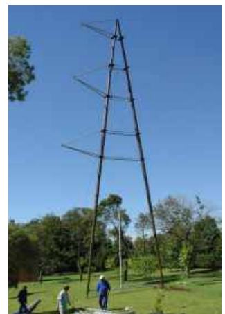
Torre Delta na configuração chainette.
