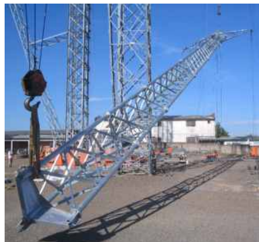
Facilidade de içamento. TET suspensão com 36m.
