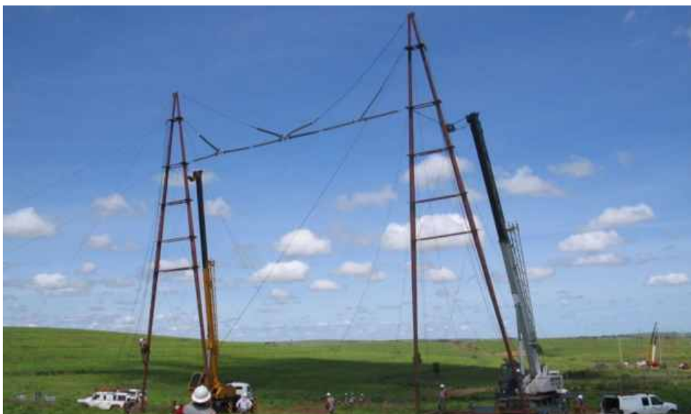
Torre Delta na configuração chainette.
