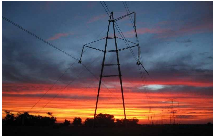
Torre Delta montagem convencional.
