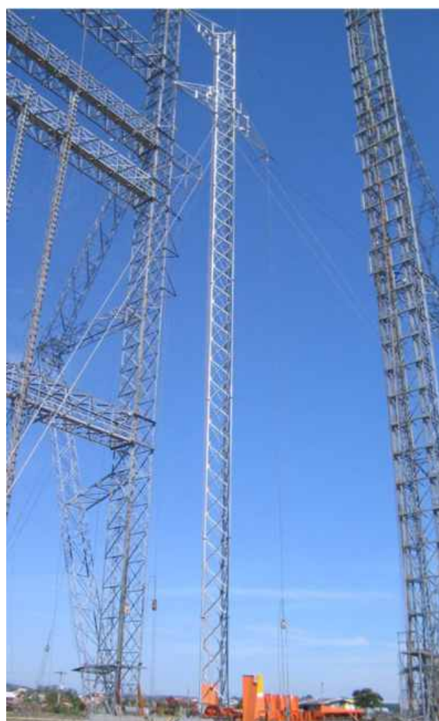
Torre TET na estação de testes.
