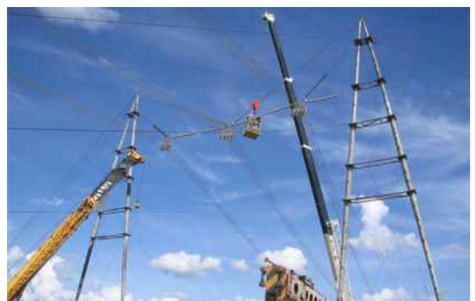
Torre Delta na configuração chainete.
